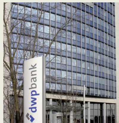
Edificio del banco en Dusseldorf
