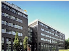
Administration centre, Vattenfall Europe Berlin
