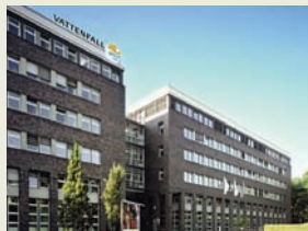
Administration centre, Vattenfall Europe Berlin
